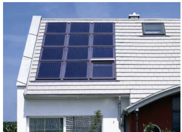
Solarkollektoren dienen der Warmwasserbereitung.
