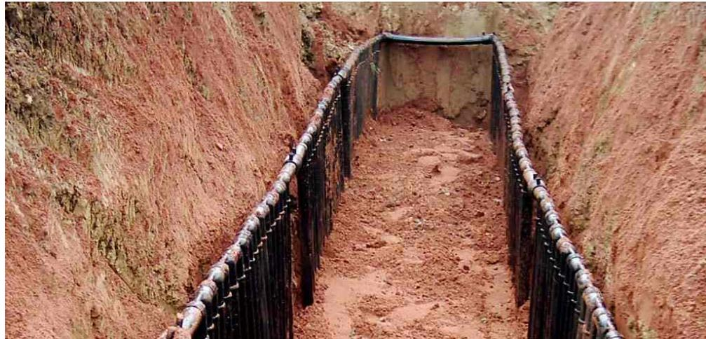
Der erforderliche Platzbedarf liegt beim ca. 1,0 - 1,3 fachen der beheizten Fläche, also bei ca. 300 - 400 m<sup>2</sup> pro Haus. Problematisch bei der vertikalen Variante ist, dass die Wärme in den Wintermonaten von unten an den Kollektor heranströmen muss, wenn der Oberboden gefroren und für Wasser undurchdringlich ist. Das führt zu einer erheblichen Verkleinerung der Entzugsfläche und damit, bei Unterdimensionierungen, zu Eisbildung und Ausfall der Anlage.
