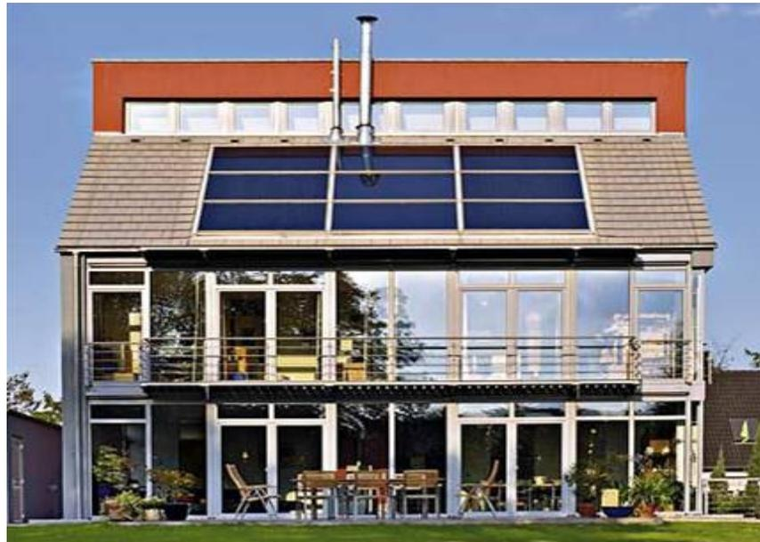
Die negativen Effekte durch ungünstige Ausrichtung und Unterschiede in den Wirkungsgraden der Kollektoren können zum großen Teil durch Vergrößerung der Kollektorfläche ausgeglichen werden, bis die gewünschte Wärmeleistung erreicht wird.
