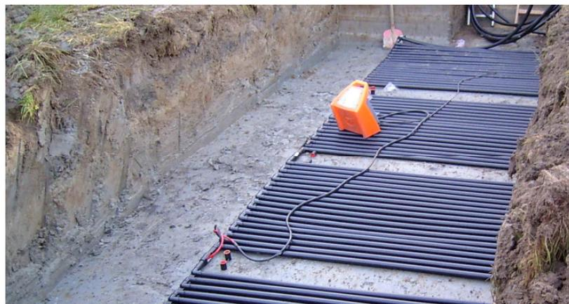
Um dennoch über Kollektoren Umweltwärme aus dem Erdreich aufnehmen zu können, sind platz sparende Kollektorformen entwickelt worden. Die einfachste Form ist der **Kompaktkollektor**. Der erforderliche Platzbedarf liegt beim ca. 1,2 - 1,5 fachen der beheizten Fläche, also bei ca. 350 - 450 m<sup>2</sup> pro kleinem Mehrfamilienhaus.
