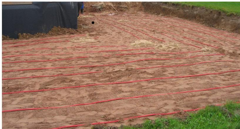
Der Platzbedarf einer Flächenkollektors liegt für den Wärmebedarf eines Hauses ab 2012 bei ca. der 1,4 bis 1,8-fachen beheizten Fläche des Hauses, also bei ca. 400 - 550 m<sup>2</sup> pro Haus mit drei Wohneinheiten. Die Grundstücksgrößen in Mannheim-neu stellen eine Freifläche dieser Größe wahrscheinlich nicht zur Verfügung.
